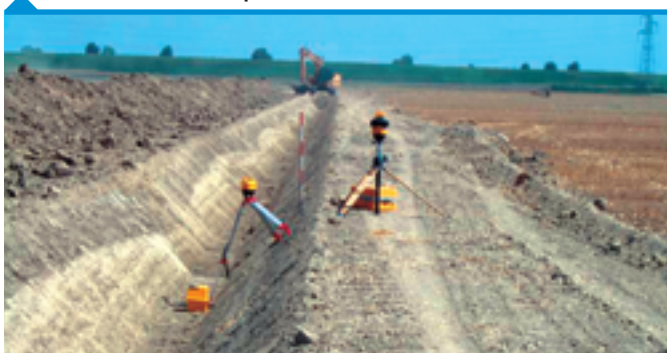
... Scavo ex-novo con scarpata a 45°.
