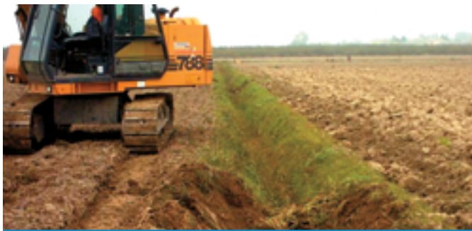
... Risezionamento scarpata da 53°.
