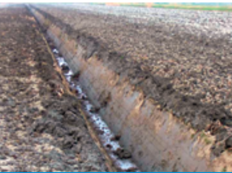
Lavoro effettuato da scavafossi rotativo.
